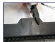
Découper des trous pour le passage des câbles
